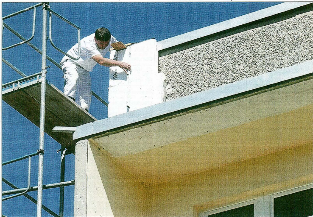
Dämmung einer Fassade in Aschersleben.
